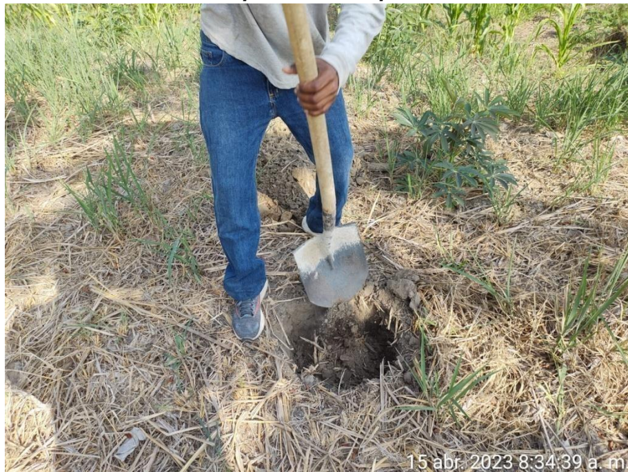
Excavación para colocar puntos de amarre
