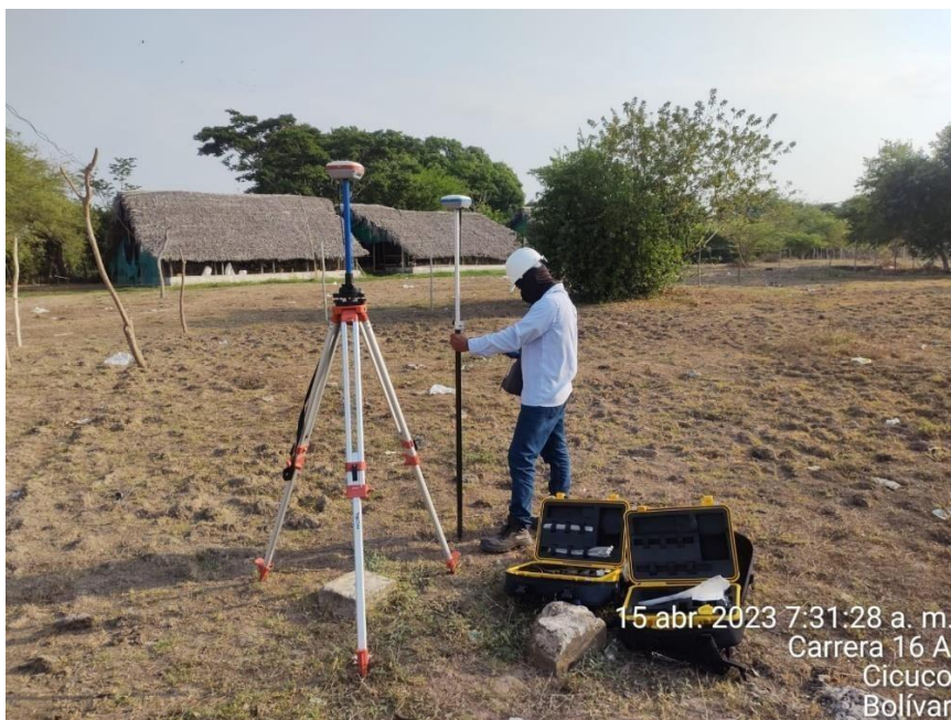
Ilustración 3 - Armado de RTK
