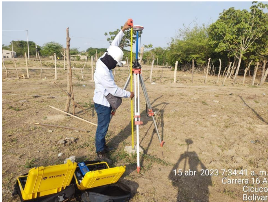
Ilustración 3 - Armado de RTK
