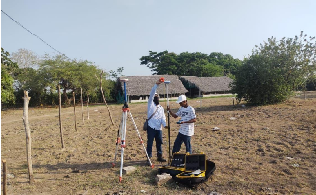
Ilustración 2 Inicio Levantamiento topográfico
