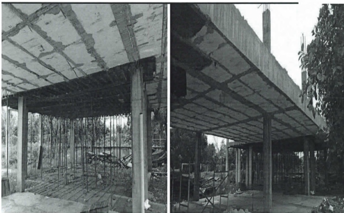
Placa aligerada y placa de contrapiso
