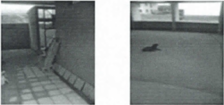
Instalación de Piso
